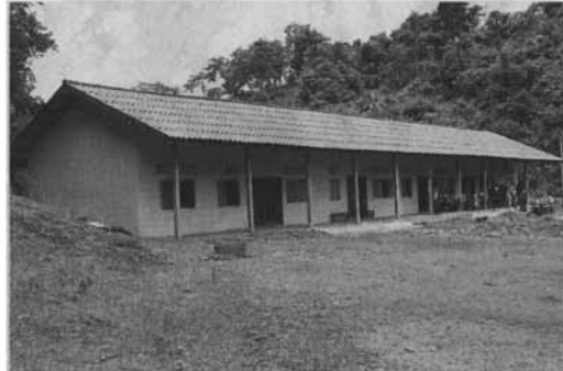
完成した小学校の校舎(提供写真)
